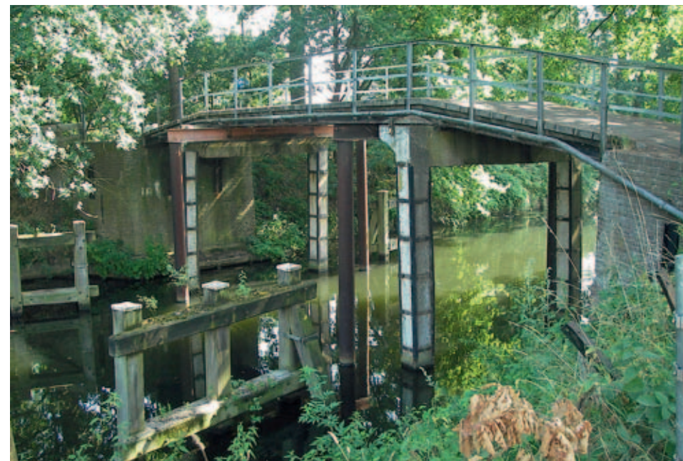
Oudvensebrug over het Eindhovens kanaal tussen Mierlo en Brandevoort. (foto: Chris Peel)
